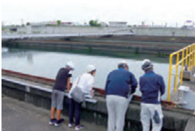
吉野川北岸工業用水道浄水場では、沈殿池や配水池などを見学しました
