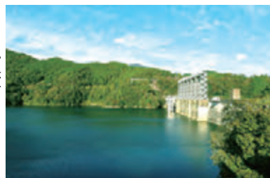
四国の水がめ「早明浦ダム」
